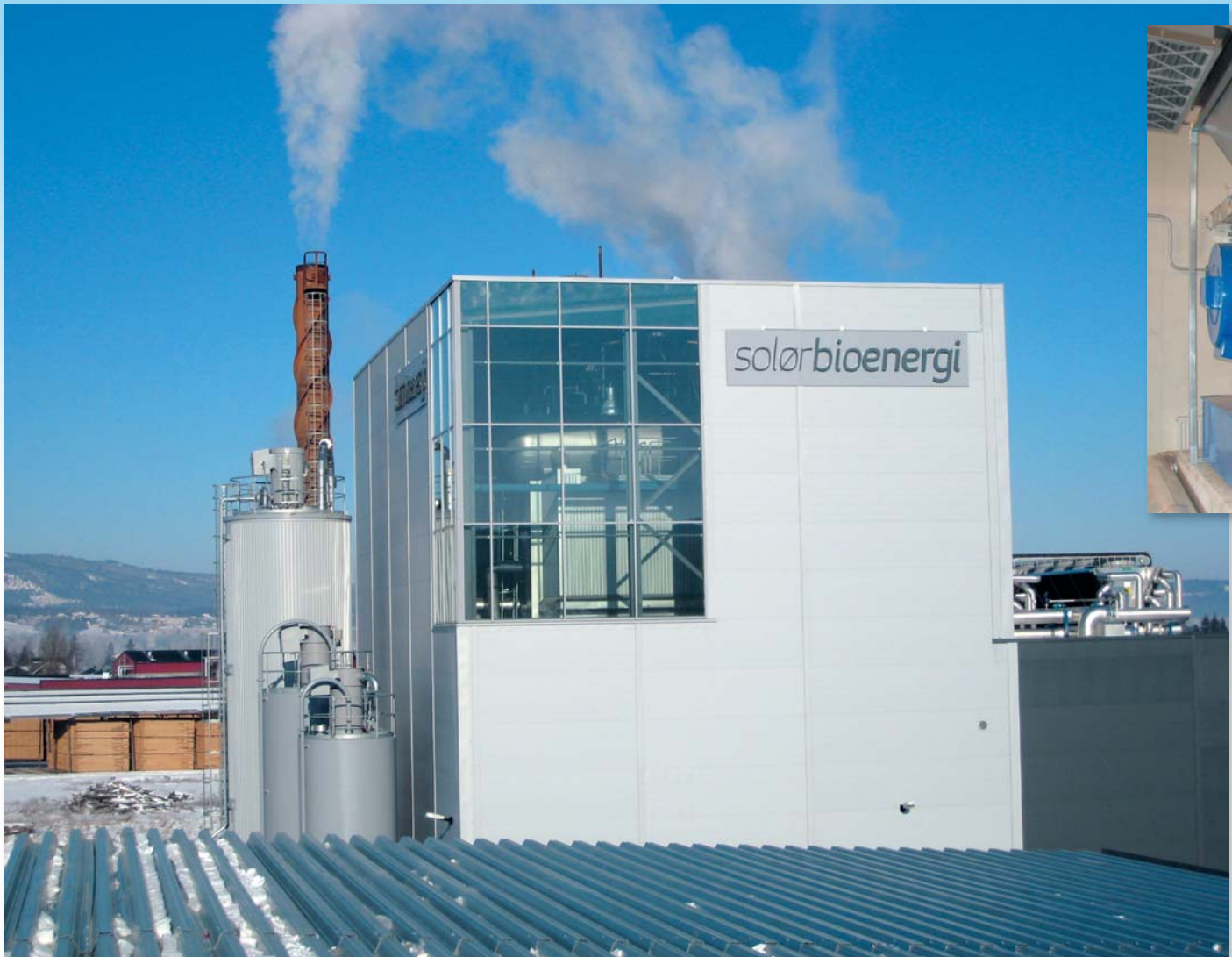
Kraftvarmeverket på Kirkenær testkjøres i disse dager.
