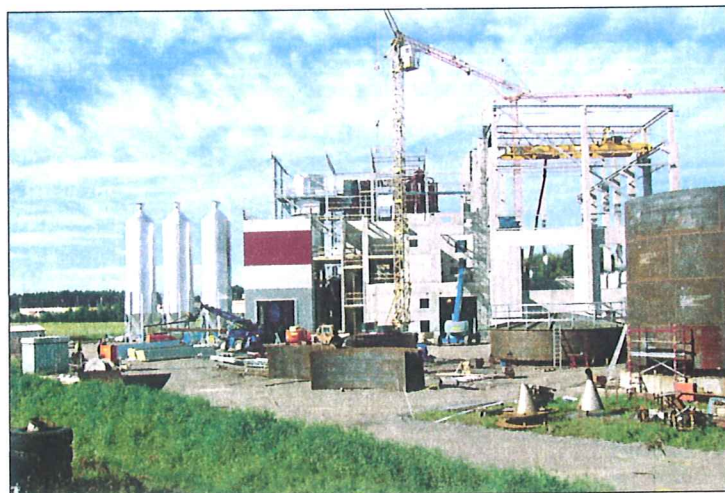
Tidaholms kraftvärmeverk under byggnationen. Omkring 175 miljoner kronor har det nya kraftvärmeverket kostat.
