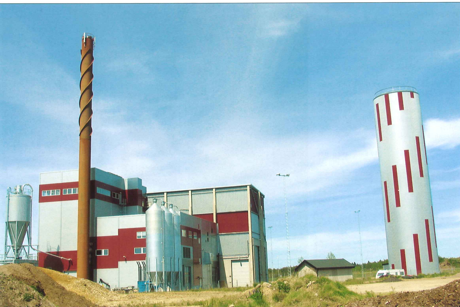
Det nya kraftvärmeverket i Tidaholm kommer att gå i provdrift tills juni. Då tas anläggningen över av Tidaholms Energi.
